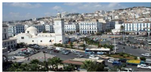
Figure 23; Immeuble mixte, place des martyrs (Google image)
