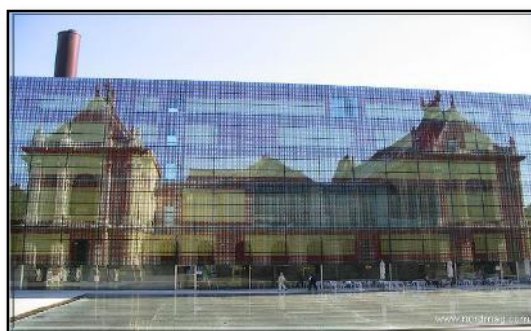
Figure 44; façade en verre (Google image)
