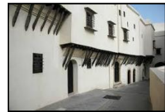
Figure 16; vue sur K'bou du Bastion 23 (Google image)
