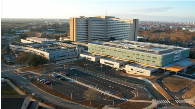
Figure 28 Parking et aménagement extérieur
