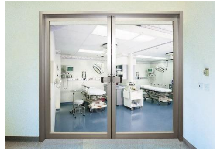
Figure 106 Porte de laboratoire
