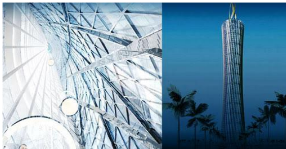
Figure 46: vue intérieur/extérieur Burdj Taqa
