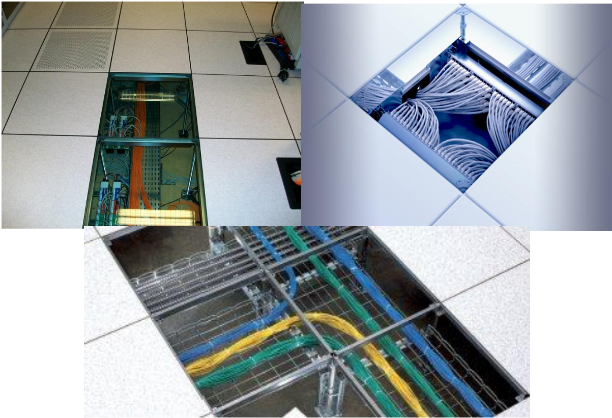
Figure 189: exemple d'un plancher technique 151
