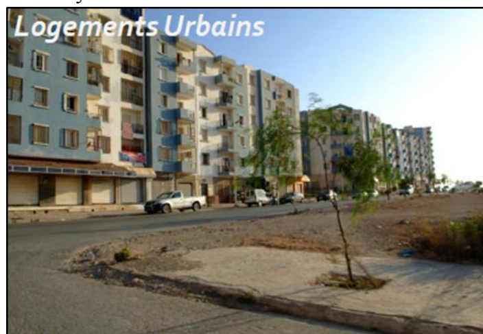
Figure 124 : Immeuble d'habitat collectif sur le site 118
