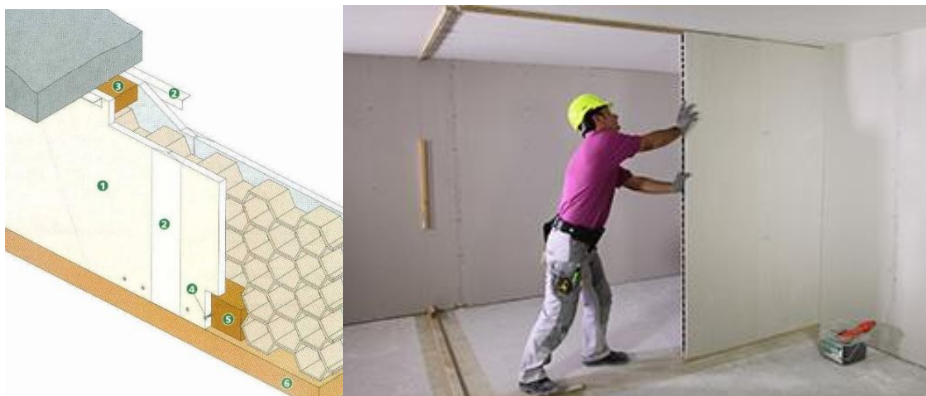
Figure 179: séparation en panneau alvéolaire
