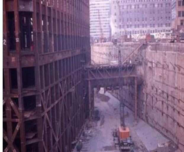
Figure 142: système des parois moulées
