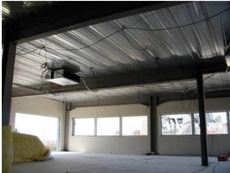
Figure 77: exemple d'utilisation d'une dalle cofradal
