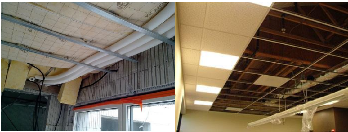
Figure 186: passage des équipements au-dessus d'un plafond suspendu
