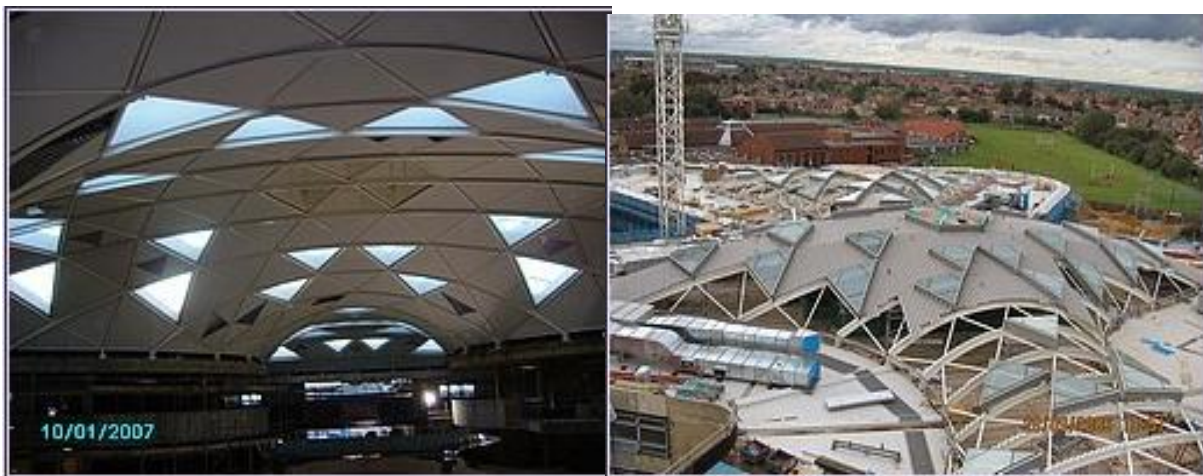
Figure 170: exemple de couverture tridimensionnel
