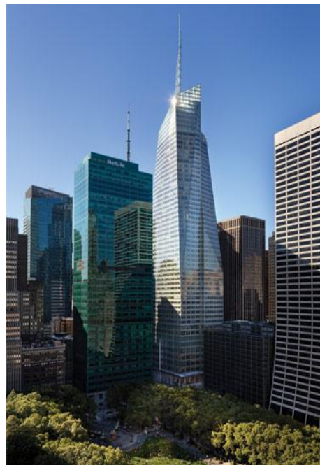
Figure 49: différentes vues sur la Bank Of America Tower
