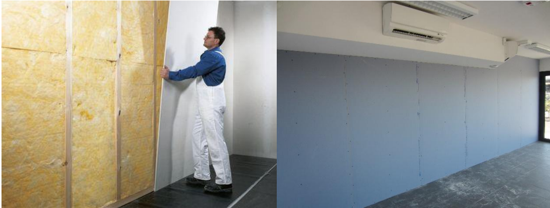
Figure 177: séparation en cloison double parement
