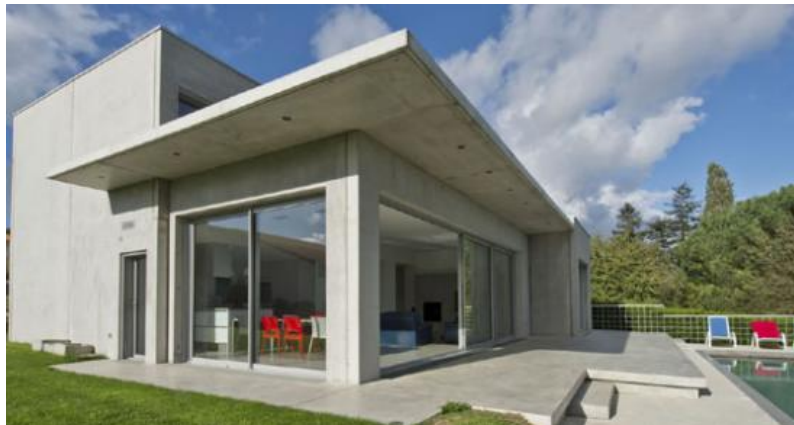
Figure 6: construction en béton armé
