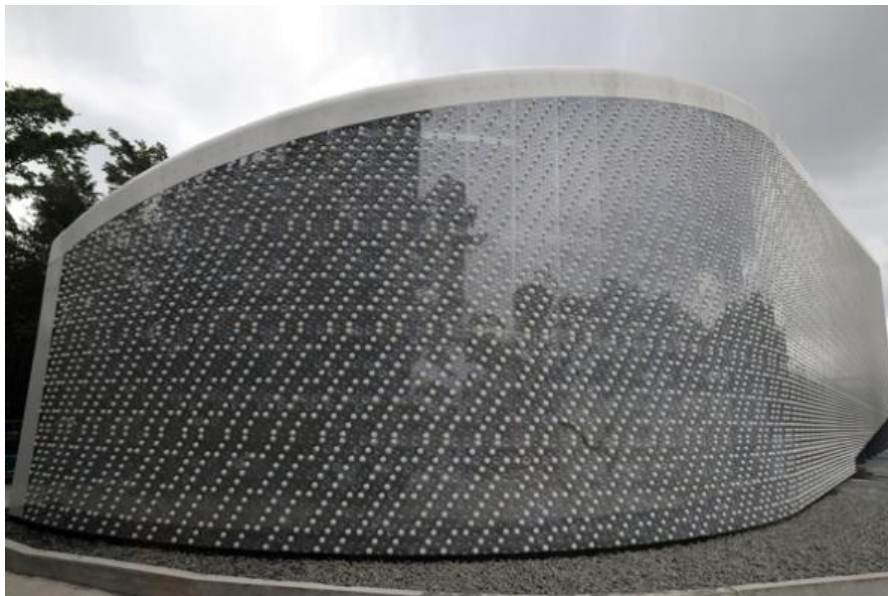
Figure 13: construction en plastique
