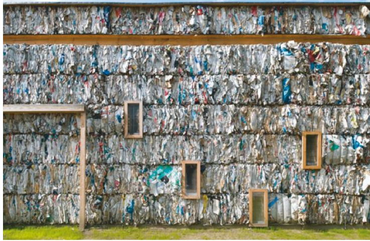
Figure 12: construction en papier
