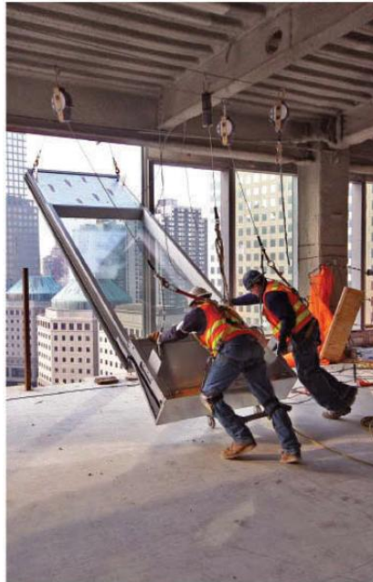
Figure 89: Système Unitized employé dans le One World Trade Center 78
