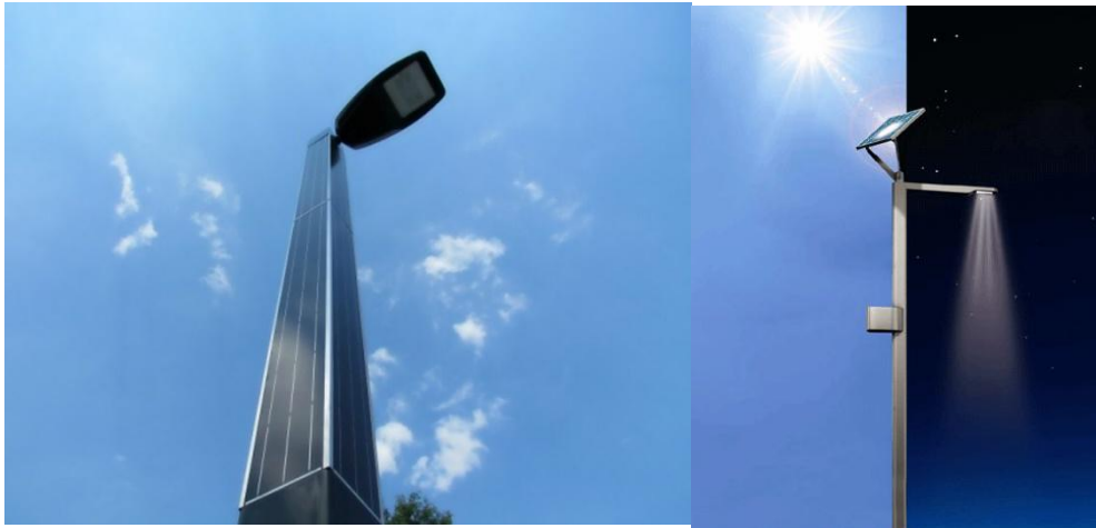
Figure 197: exemple d'éclairage solaire 157
