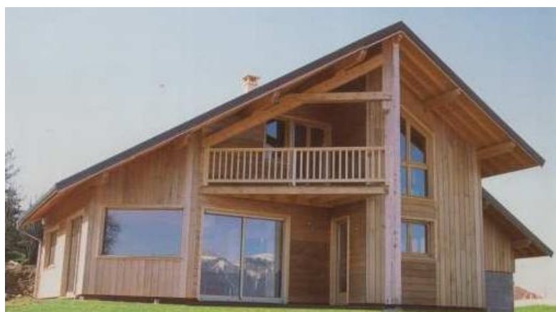
Figure 2: construction en bois
