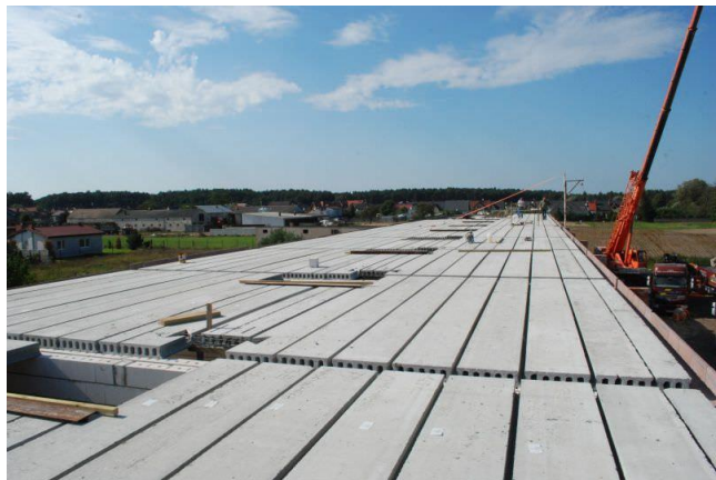
Figure 86: exemple d'utilisation de dalle alvéolaire
