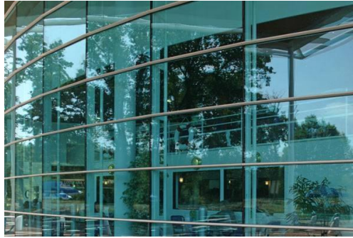
Figure 71 : mur rideau en grille
