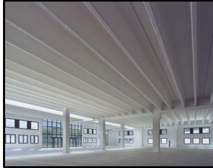
Figure 50 : plancher nervuré
