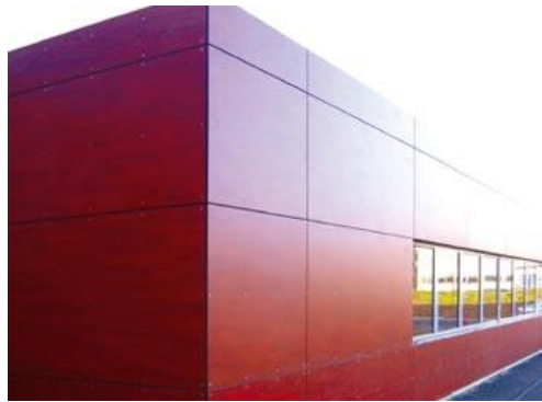
Figure 82 : revêtement de mur extérieur
