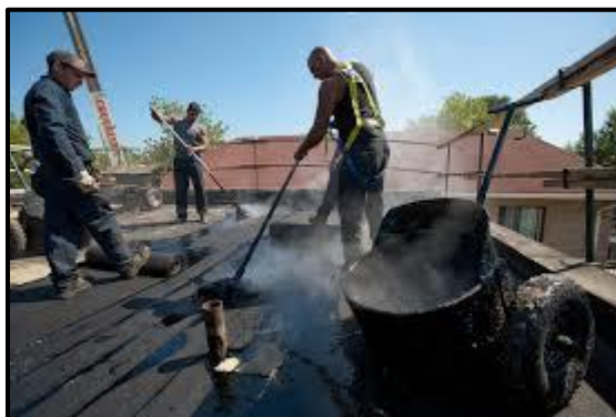
Figure 61 : étanchéité en bitume
