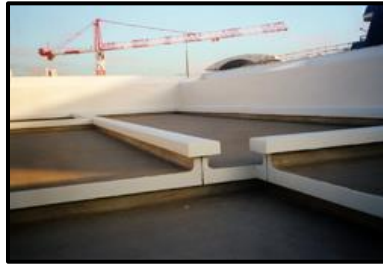
Figure 62 : étanchéité en résine
