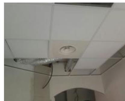
Figure233 : faux plafond en plaque hydrofuge
