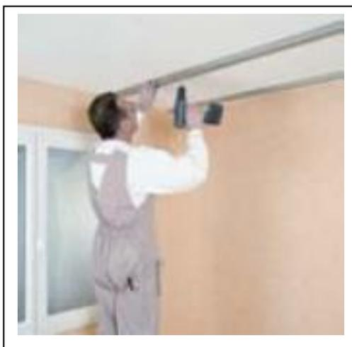
Figure232 : la réalisation d'un faux plafond
