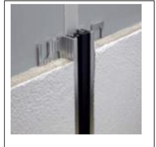
Figure223 : Couvre joint des murs
