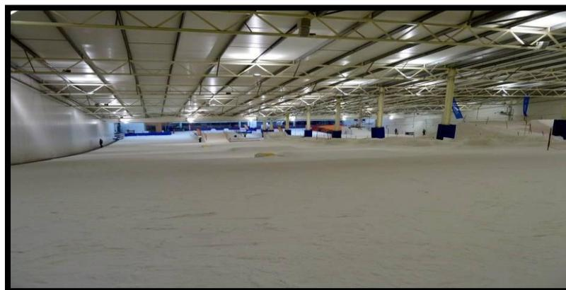
Figure 72 : exemple d'utilisation de poutre a treillis dans un ski dôme<sup>2</sup>
