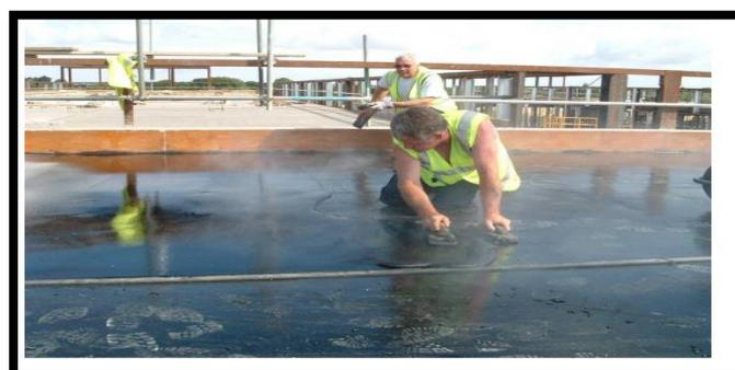
**Figure 82 : pose de membrane liquide<sup>2</sup>**
