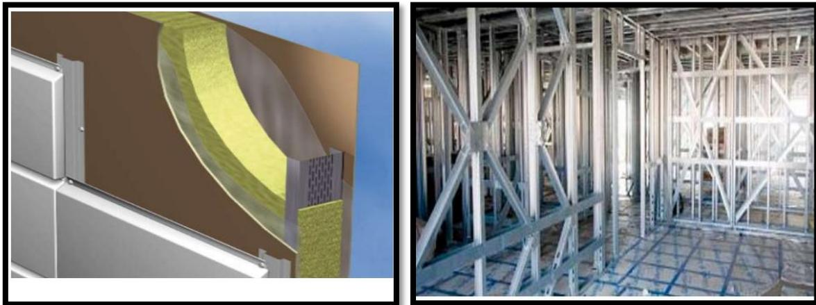
**Figure 86 : exemple de mur de remplissage extérieur**
