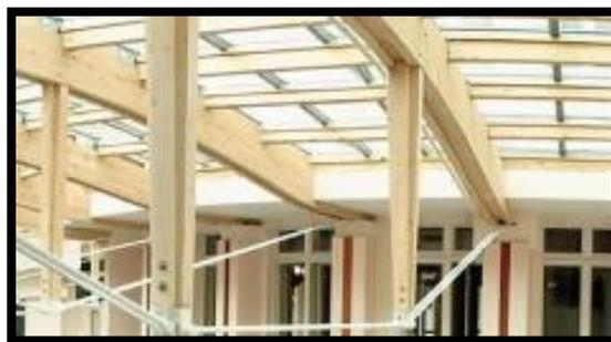
Figure 57 : structure d'une verriere
