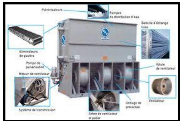
Figure 116: détaille de refroidisseur
