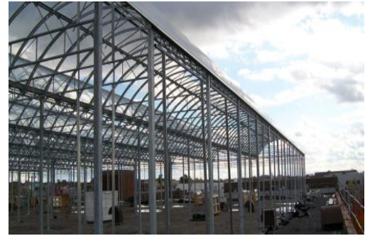
Photo1 : la charpente de la serre
