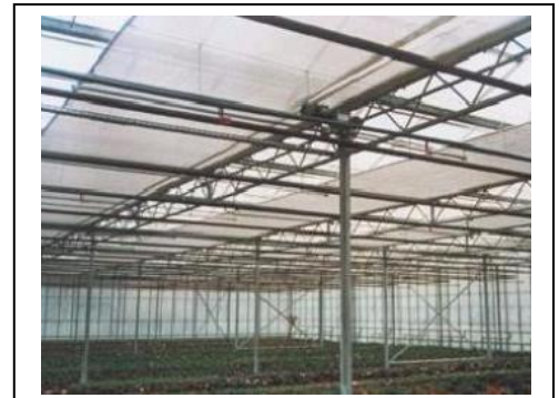
Figure91 : récupérateur de chaleur
