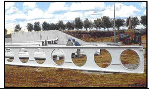
fig 76:poutre alvéolaire
