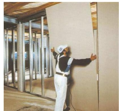
Figure 100:cloison en plâtre
