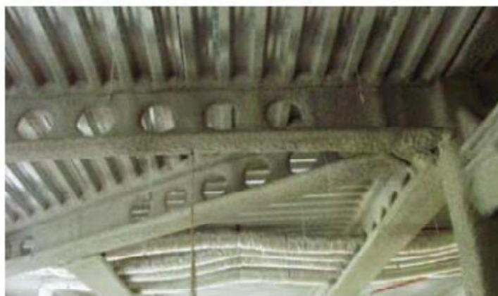
Figure 31 : Protection par flocage d'une poutrelle ACB®
