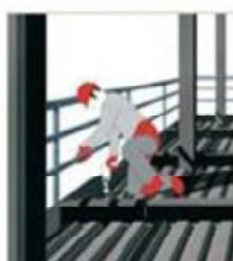
Fixation et couvrage du bac
