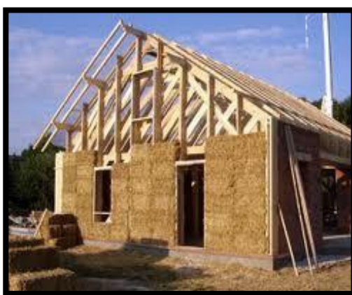
Figure 39 revêtement extérieur en botte de paille
