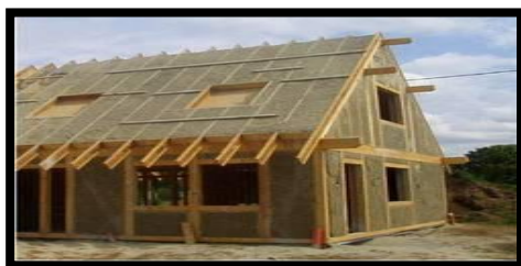
Figure 41 Revêtement extérieur d'une maison en béton de chanvre
