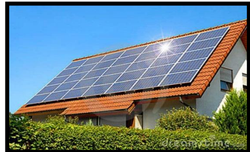
Figure 55 Panneaux Solaire dans la toiture
