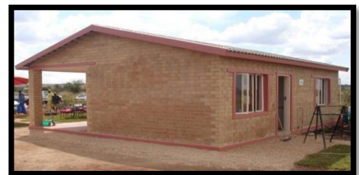
Figure 48 Revêtement extérieur en brique de terre compressée
