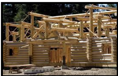
Figure 38 Ossature en bois
