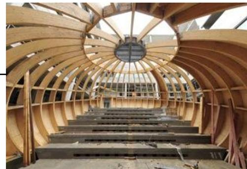
Charpente lamellé collé Avec poutre cintré
