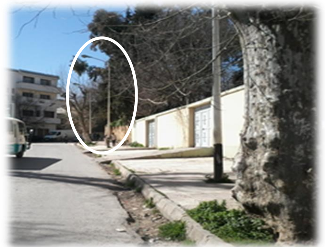
Figure 48 : photo du côté est du terrain montrant le poteau électrique
