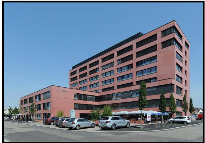
Figure 21. Photos de façade principale du centre 47
