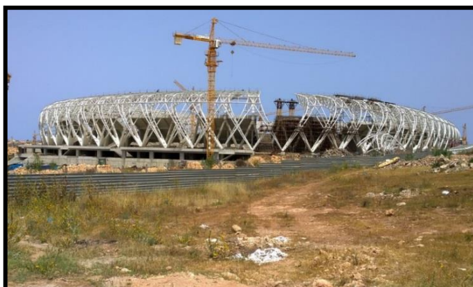
Figure 69. Le chantier de grand complexe olympique de Bir El Djir
