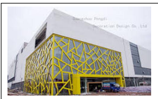
Figure 154 traitement des façades
