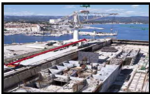
Figure 128 demi plancher caisson assemblé sur zone de travaux
