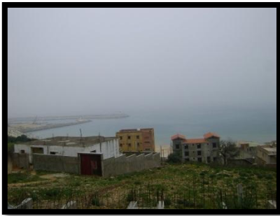
Figure : nouveau port en cours de construction, prise par ziane cherif,
