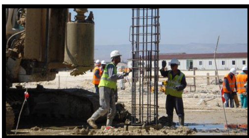
Figure 133 forage des pieux
