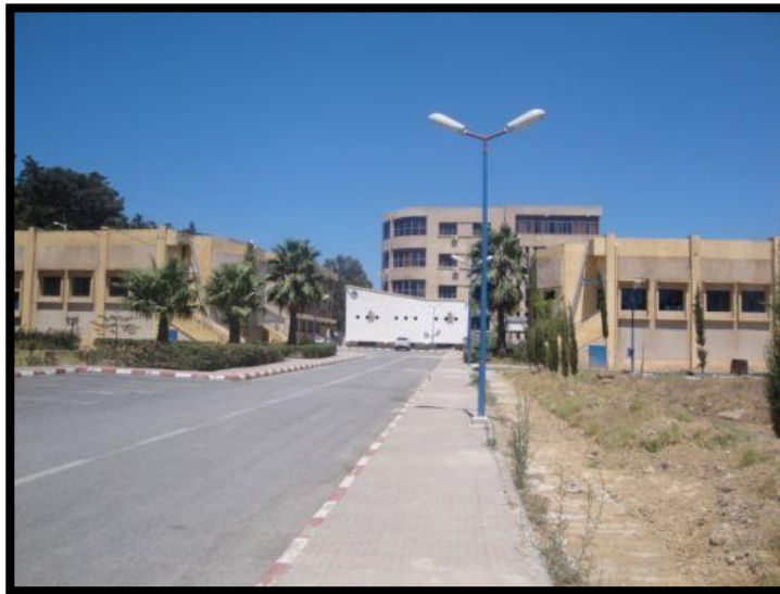
Figure 31 façade de l'institut
