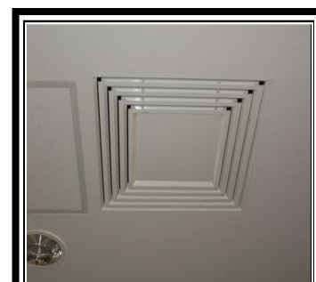
Figure 147 bouche d'extraction
