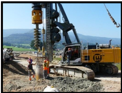
Figure 133 forage des pieux
