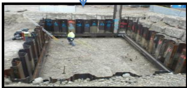
Figure 131 pompage de l'eau
