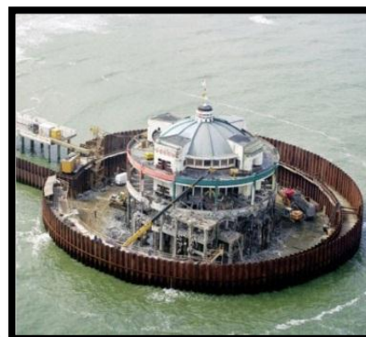
Figure 132 palplanche entouré d'un projet
