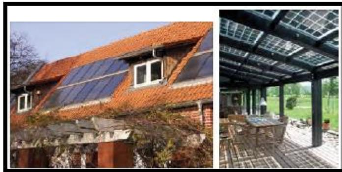
**Fig. (10)** Intégration architecturale des panneaux solaires
