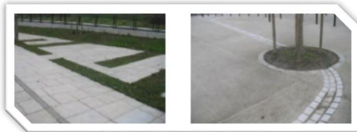
**Fig. (12) :** Bandes gazonnées d'infiltration    **Fig. (13) :** rigoles d'arrosage et de circulation d'eau
