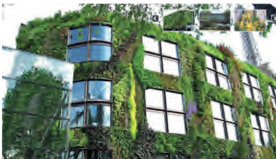
figure façade végétalisée
