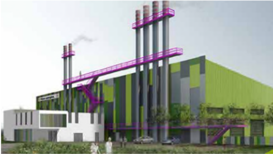
Station de la chaufferie Dijon
