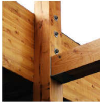
Photo 25 : Assemblage des poutres primaires sur les poteaux Source : guide pratique pdf
