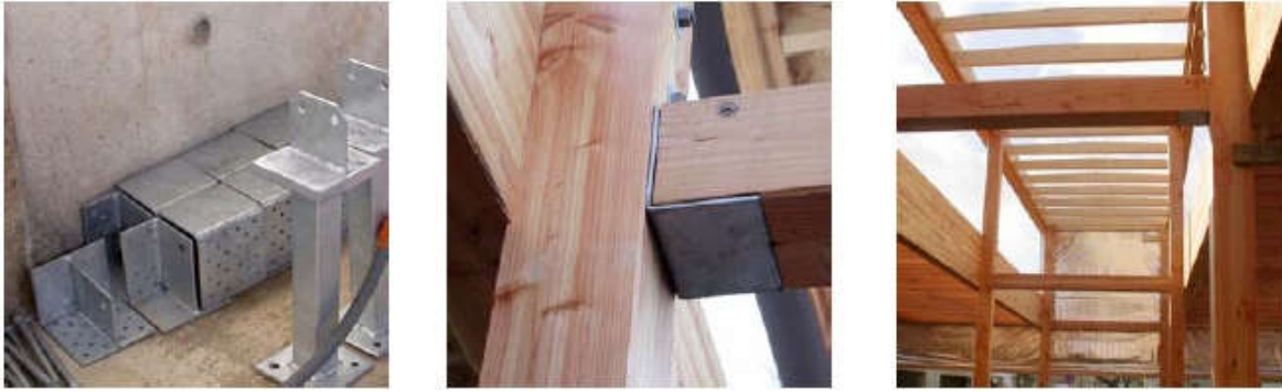
Photo 27: Chantier de la structure primaire Source : guide pratique pdf
