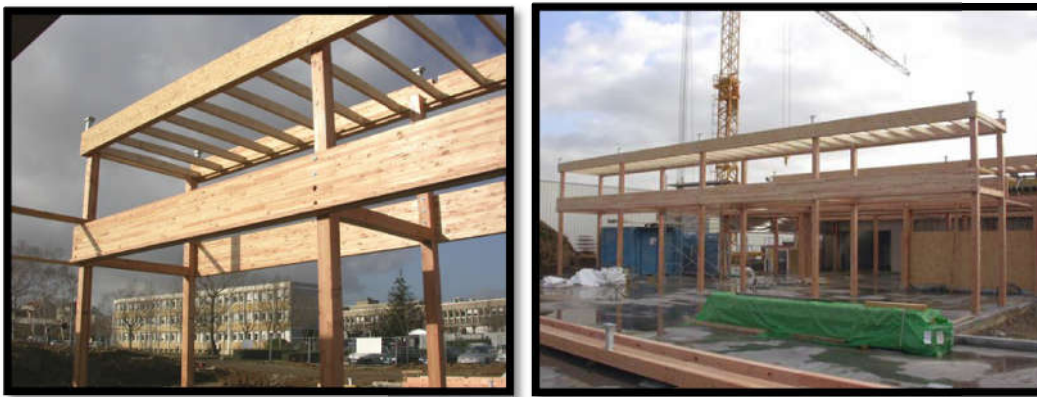
Photo 20 : Structure primaire de l'ossature bois Source : guide pratique pdf
