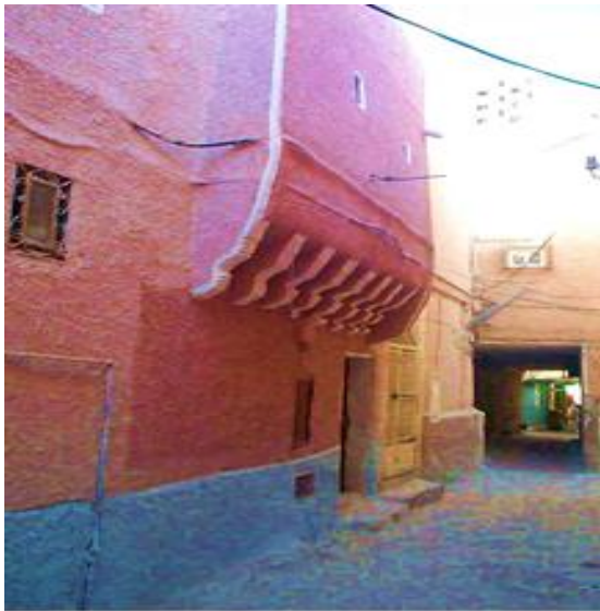
الصورة 101: بعد عملية الترميم لواجهة مسكن بمدينة غرداية.
