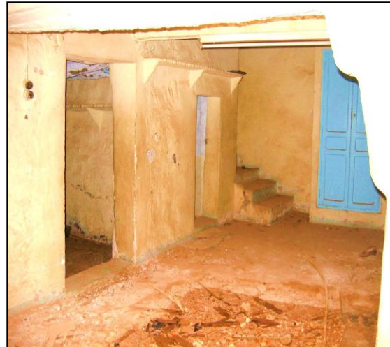
الصورة 76: تقادم الأرضية وتشققها في مسكن بمدينة غرداية.
