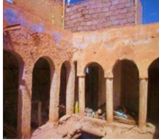
الصورة 90: قبل عملية الترميم الطابق الأول في مسكن بمدينة غرداية عن OPVM.
