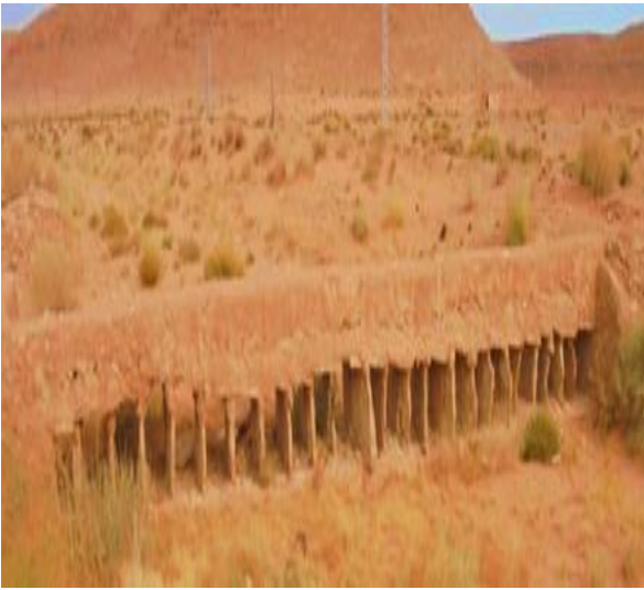
الصورة 33: أنظمة تقاسيم مياه الوديان بساقية بوشمجان في مدينة غرداية.
