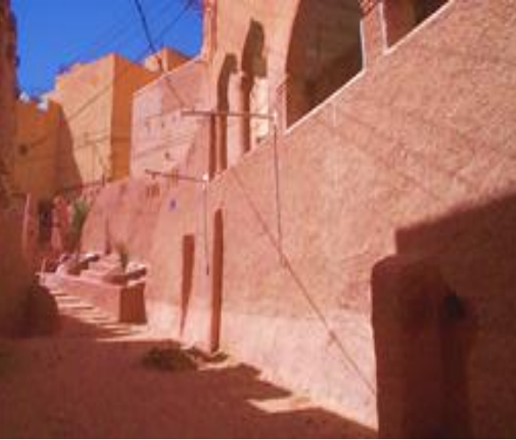
الصورة 105: بعد عملية ترميم سوق نونة بمدينة العطف.
