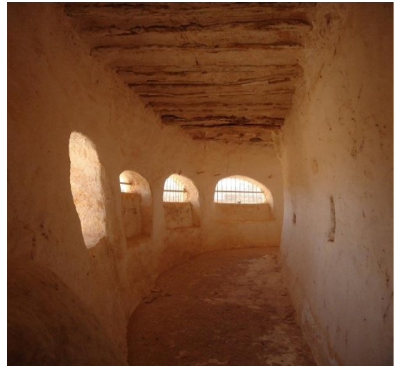
الصورة 46: المصلى بعد عملية الترميم سنة 2002م عن OPVM.
