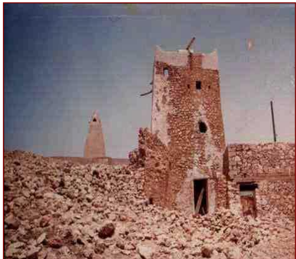
الصورة 40: عمليات الترميم للوحدات المعمارية بقصر بنورة القديم عن OPVM.
