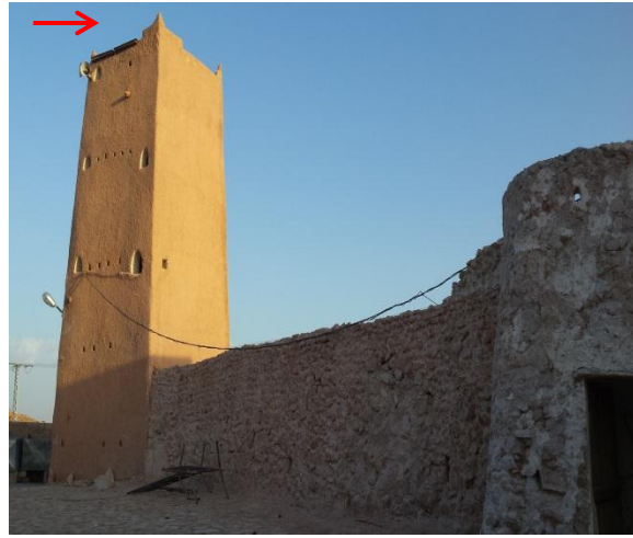
الصورة 116: برج بوليلة في مدينة بني يزقن.
