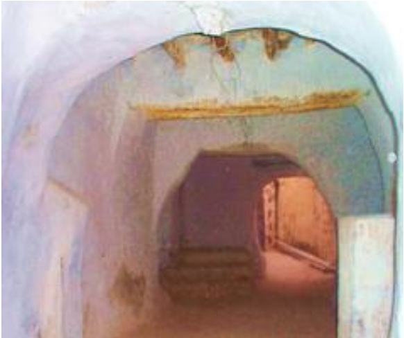
الصورة 107: بعد عملية الترميم لشارع خاص بمدينة العطف.
