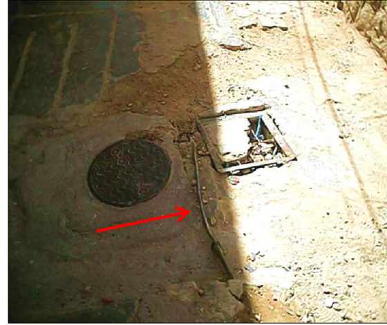
الصورة 86: تدهور قنوات المياه المعدنية بمدينة غرداية.
