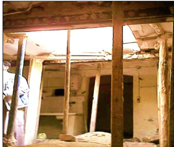
الصورة 94: قبل عملية الترميم لسقف المسكن في مدينة غرداية.
