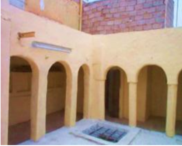
الصورة 91: قبل عملية الترميم الطابق الأول في مسكن بمدينة غرداية عن OPVM.
