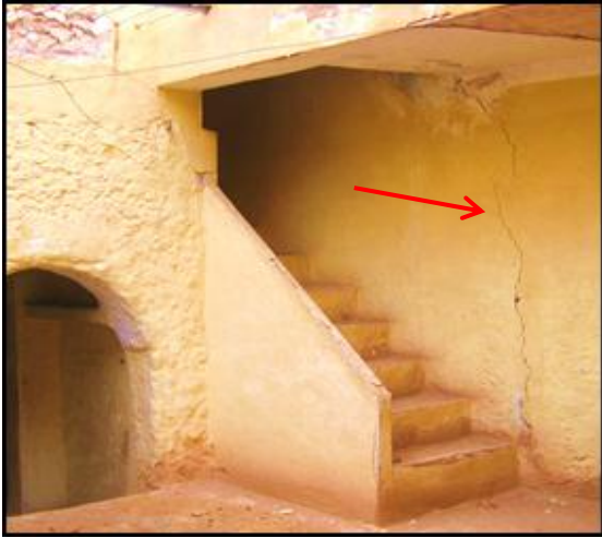
الصورة 79: التشققات العمودية داخل المسكن في مدينة غرداية.
