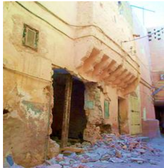
الصورة 100: قبل ترميم واجهة مسكن بمدينة غرداية.
