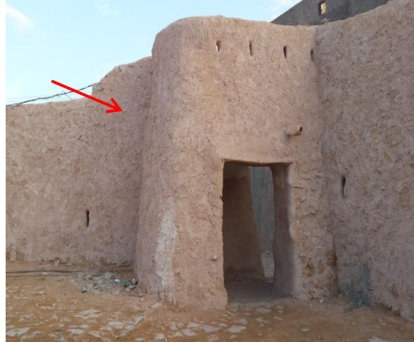
الصورة 114: الباب الفرعي الشيخ بلحاج أثناء عملية الترميم 2015م لمدينة بني يزقن.
