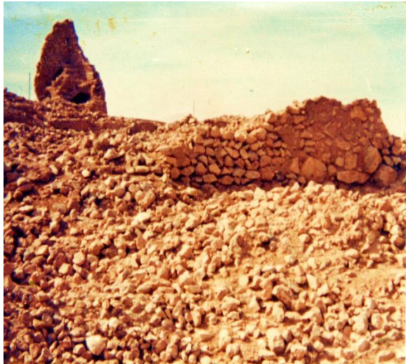
الصورة 11: مسجد ومئذنة قصر بنورة قبل إعادة البناء سنة 1983م عن OPVM.
