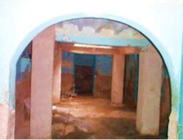
الصورة 93: بعد عملية الترميم لأعمدة صحن المسكن وأرضيته في مدينة غرداية.
