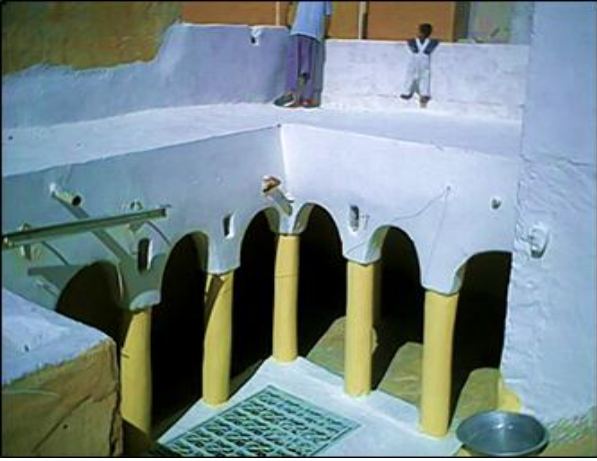
الصورة 97: بعد عملية إعادة بناء الإيكومار في مسكن بمدينة غرداية عن OPVM.
