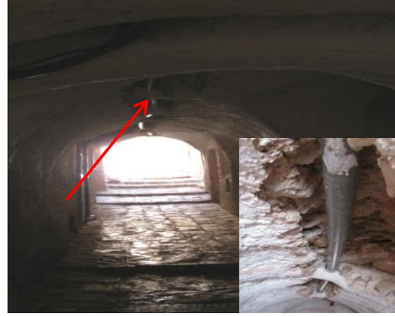
الصورة 84: موضع شبكة الصرف الصحي لمسكن في سقف السباط بمدينة غرداية.
