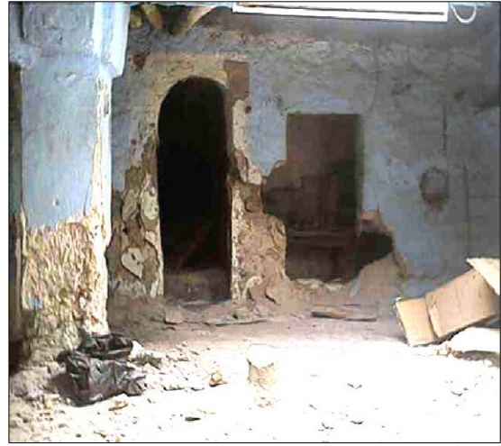
الصورة 74: تقادم العناصر المعمارية وتأثرها بالرطوبة في مسكن بمدينة غرداية.
