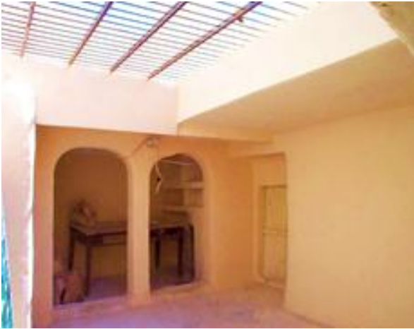
الصورة 99: بعد عملية الترميم لفتحة شبك السطح بمسكن في مدينة غرداية.
