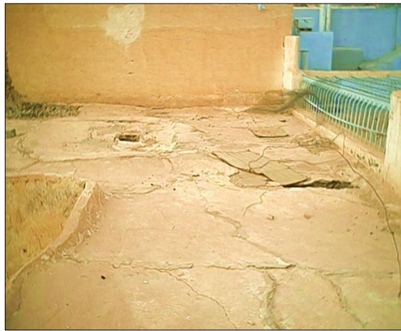
الصورة 80: تقادم أرضية السطح وتشققها في مسكن بمدينة غرداية عن مكتب الدراسات URBAT.
