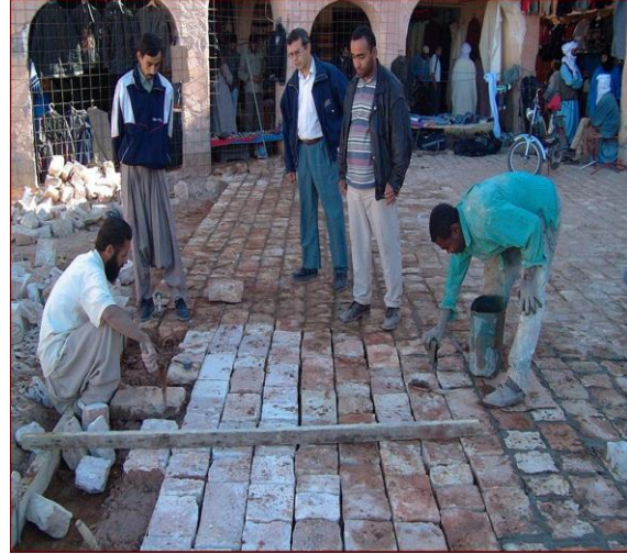
الصورة 126 : عملية إعادة الاعتبار لسوق مدينة غرداية.
