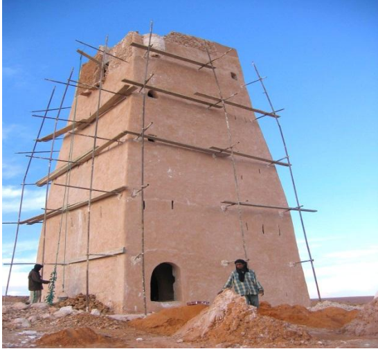
الصورة 127: رد الاعتبار لبرج انتيسة خارج مدينة بني يزقن.
