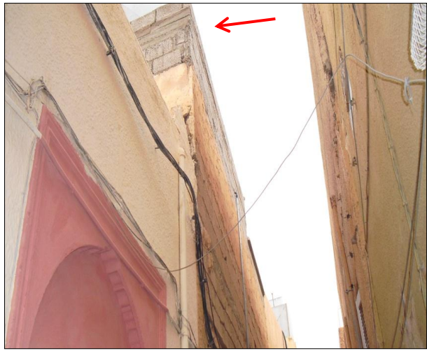
الصورة 62: المساكن التي تجاوزت العلو المسموح به بمدينة غرداية.
