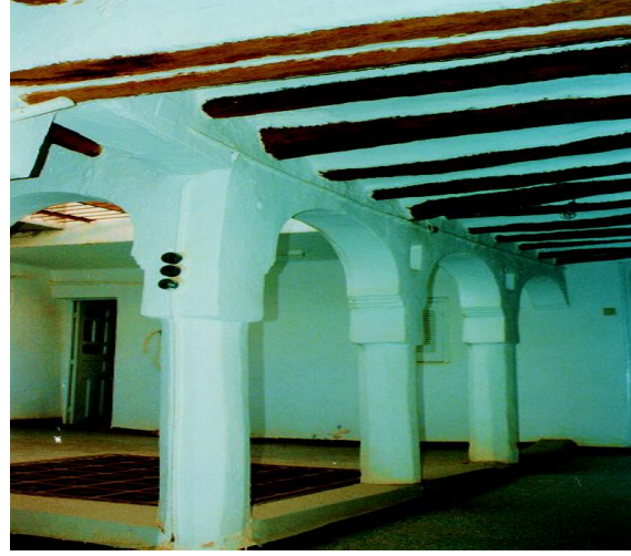
الصورة 102: الإيكومار بعد عملية الترميم بمسكن في مدينة غرداية.
