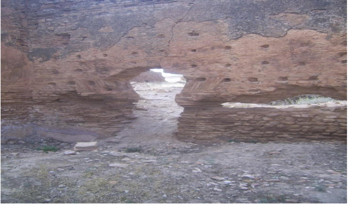
الصورة رقم 10 : الباب الداخلي للقلعة
