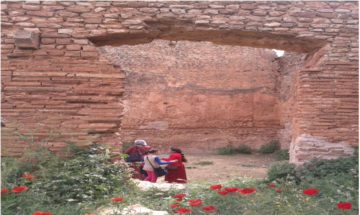
الصوره رقم 25: تقنيه opus testaceum
