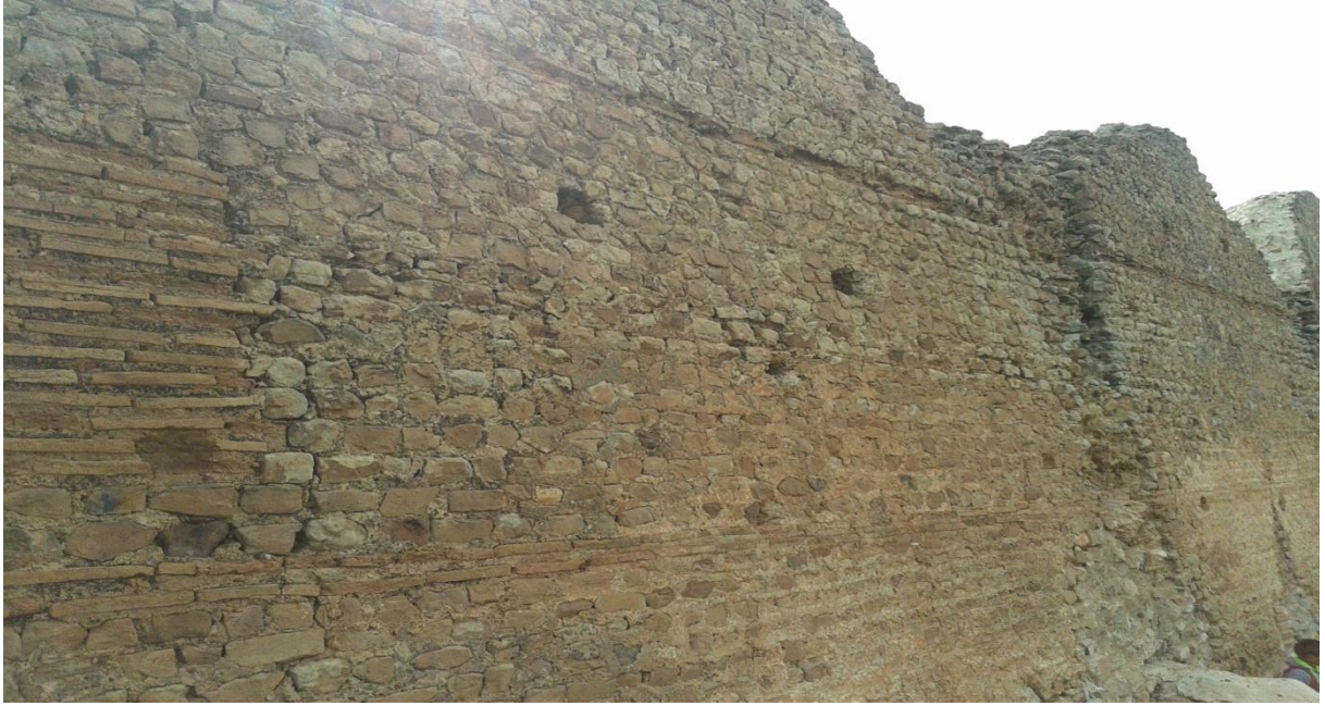
الصور رقم: 26 تقنية: opus mixtum vittatum
