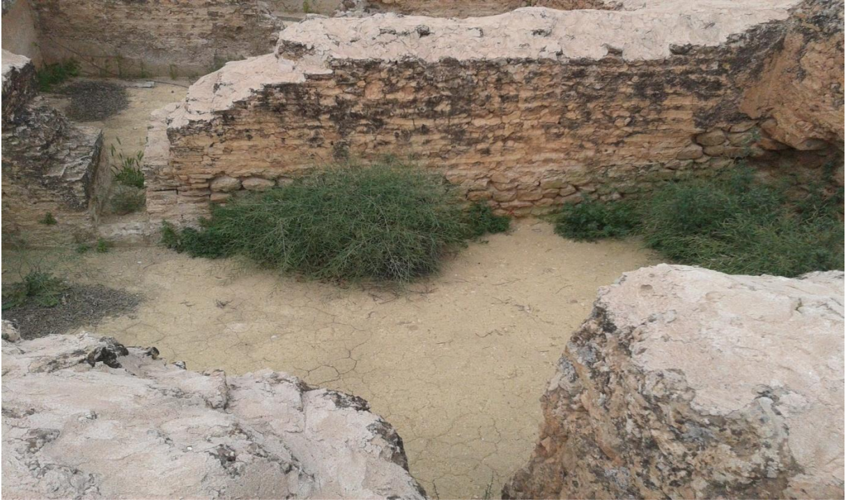
الصورة رقم 22 : ترميم خزانات المياه
