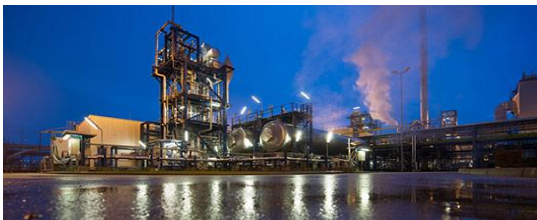
Figure 1 9: Projet pilote de centrale sans émission de CO 2 à Brandenburg, Allemagne (© 2011)
