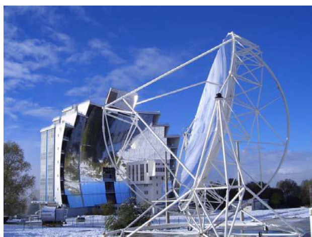
(c) Dish Stirling devant la parabole du four solaire à Promes - Odeillo.
