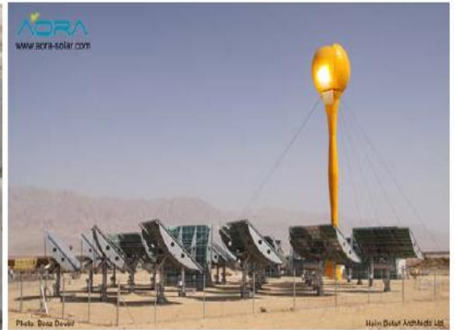
(b) Première installation de Aora dans le désert d'Arava au sud d'Israël - inaugurée en Juin 2009
