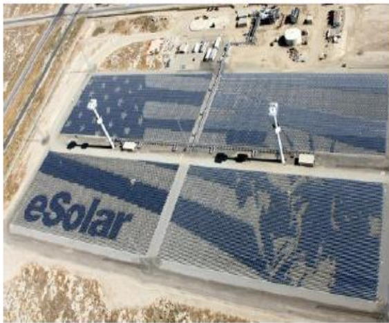
(a) Centrale Sierra SunTower de 5MW à Landcaster-Californie (construite et exploitée par eSolar)
