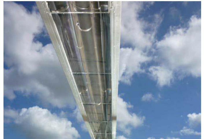
(b) Récepteur avec vitre, tube absorbeur, et second concentrateur.
