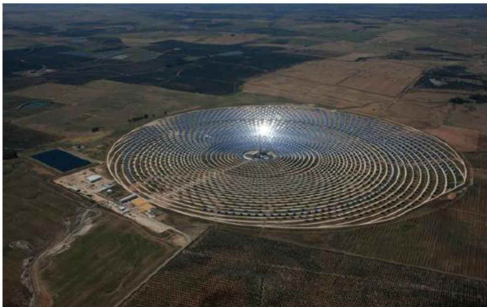
Figure II.5 : Centrale Solaire à tour Gemasolar (Espagne).
