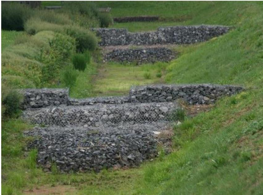
**Photo. 06 :** Réalisation des gabions par le service de Conservation des Forêts pour lutter contre l'érosion hydrique.
