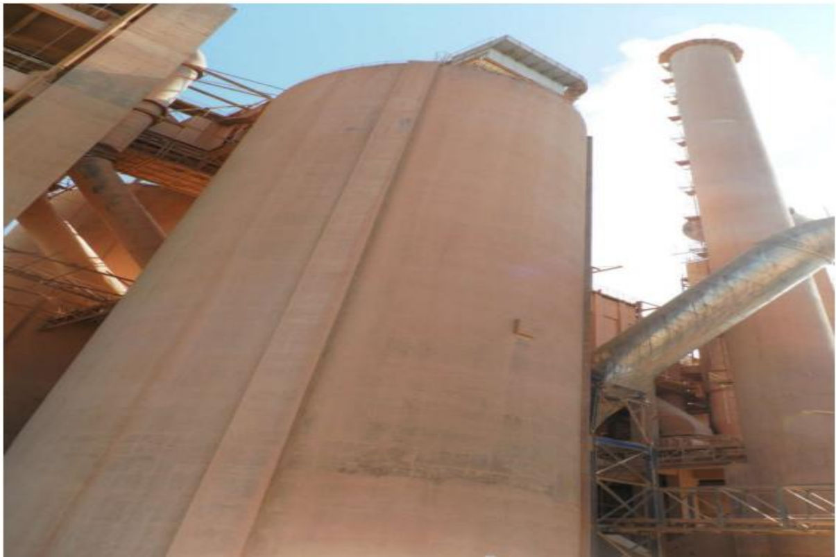
Figure I.11: Silos d'homogénéisation[25].
