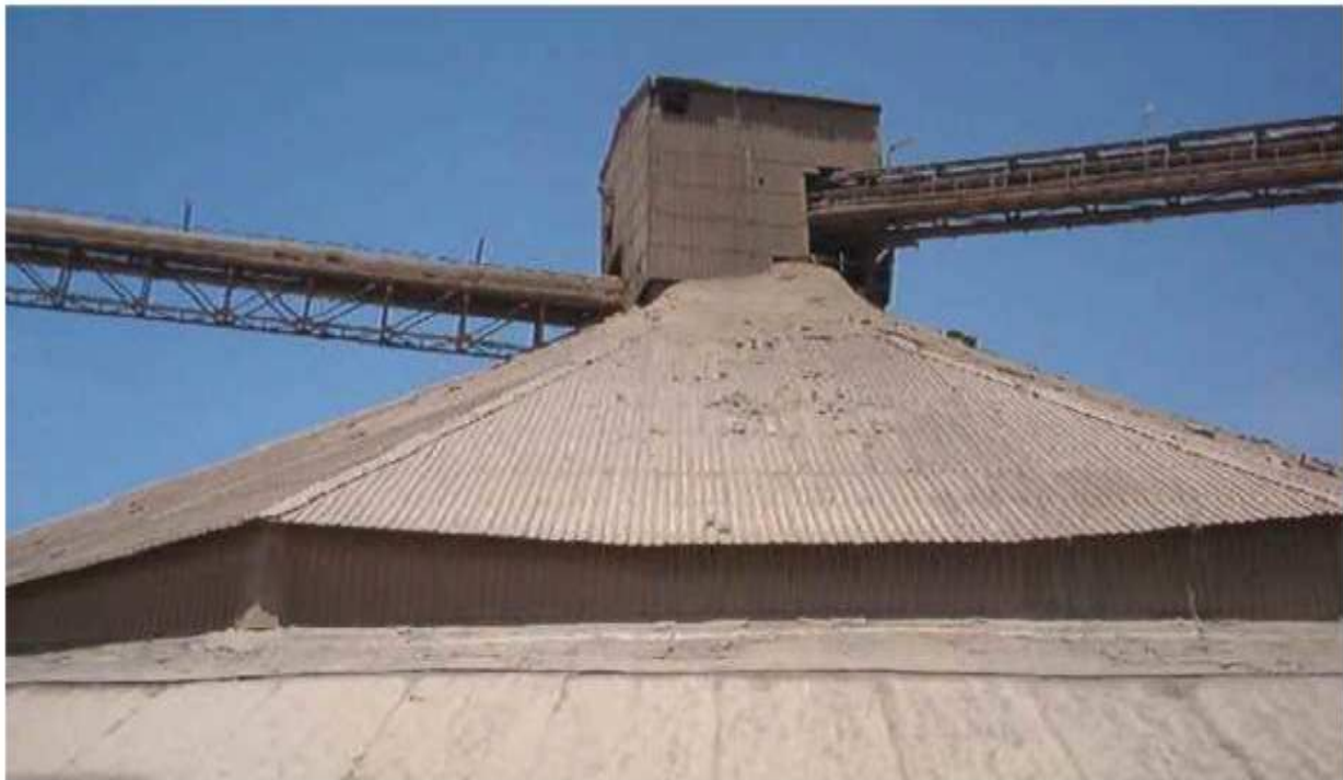
Figure 1.11: Les bulles de stockage du clinker de la cimenterie de Béni-Saf.
