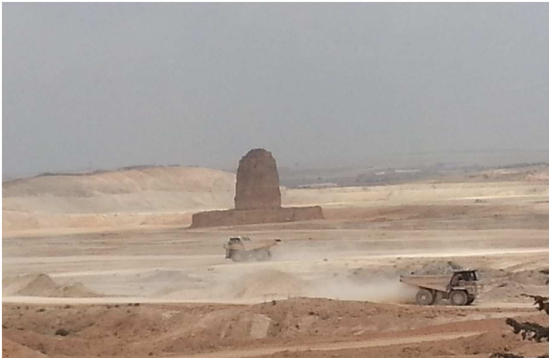
Figure I.5: Camion de transport de la carrière
