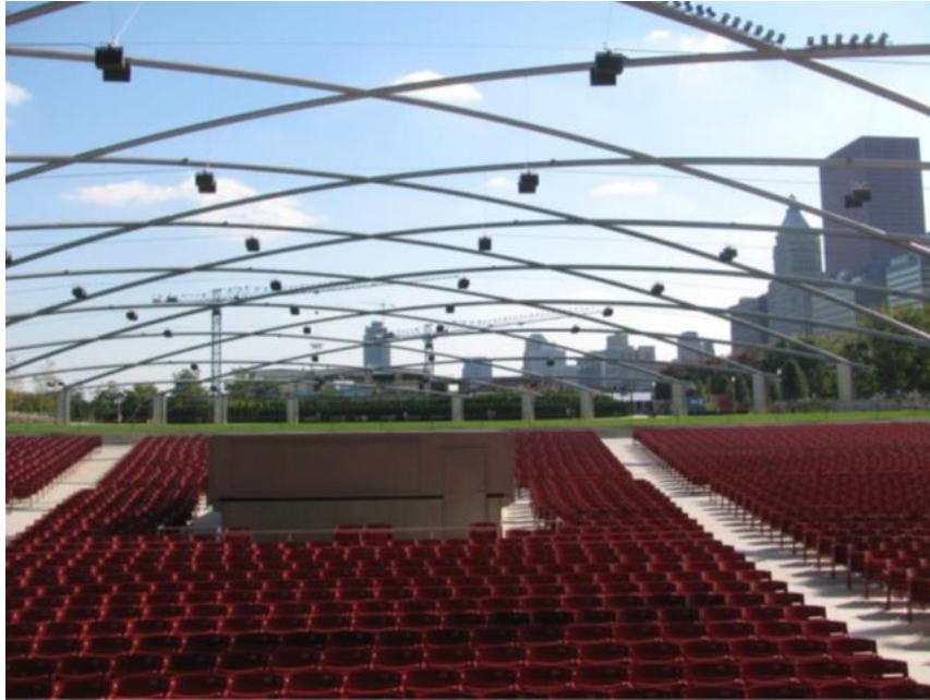
Figure 107: Salle équipée d'un système Atmos
