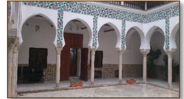
Figure 13: portique et galerie. Dar générale. Photo prise par L.M
