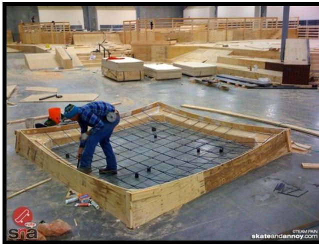
Figure 70 : la structure des modules de Skatpark
