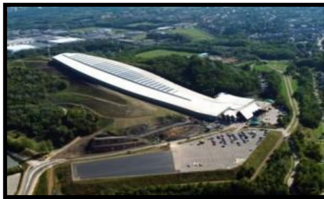
Figure 33 : vue aérienne de station de Barcelone
