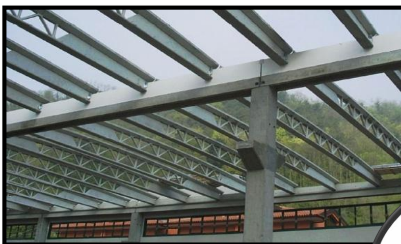
Figure 67 : une poutre en treillis
