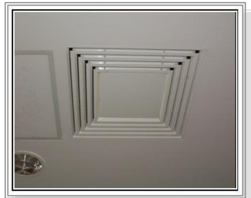
Figure 79 : bouche d'extraction
