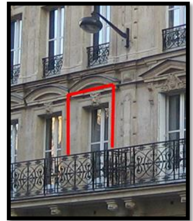
Figure 61: encadrement des portes et fenêtres
