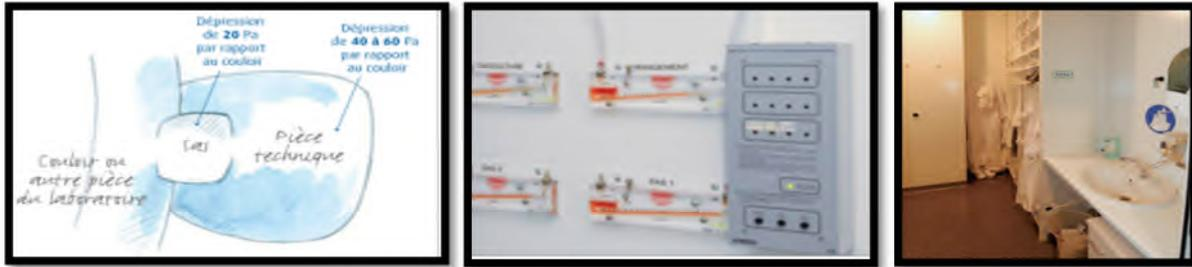
Figure 13: contrôle des niveaux de pression des sas et des salles techniques.
