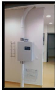
Figure 24: Système de transport des échantillons.<sup>59</sup>
