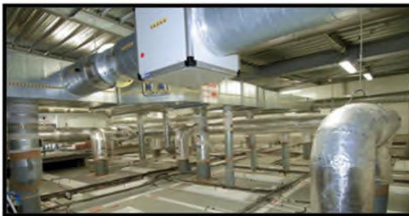
Figure 23: Système de ventilation et de filtration d'air au dessus des salles techniques de niveau de confinement 3.
