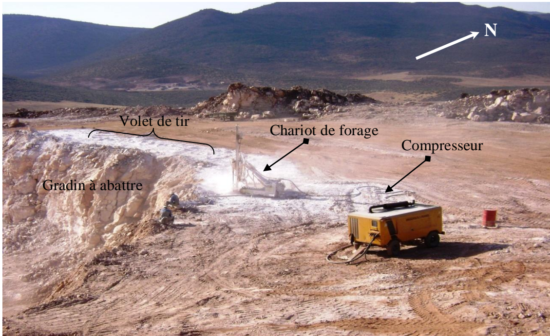
Fig. 27: Réalisation des trous de mine par un chariot de forage (ENG)
