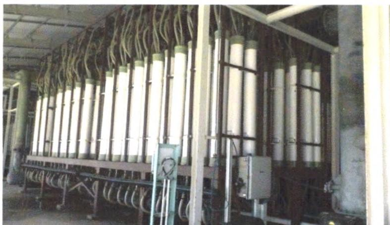
**Photo 02 :** Représentation d'un train de cartouches d'ultrafiltration.
