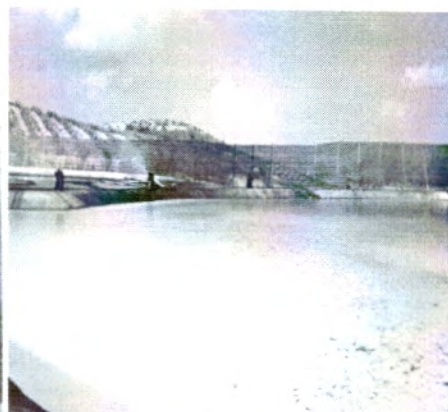
Fig n°10 : Bassin de stockage des Margines (GHEZLAOUI, 2011).
