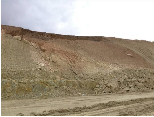
Photo I-4: glissements rotationnels pk 74+520
