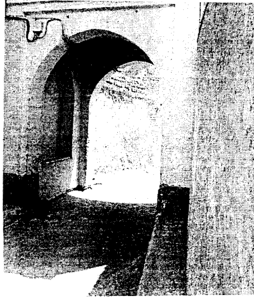
باب سيدي أحمد بن يوسف، حديث البناية لقصر تيوت -الصورة (رقم 5)
