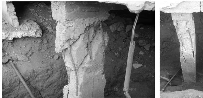
**Figures 2 et 3.** Dégradation de l'amorce-poteau due à l'absence d'armatures transversales (Site DP Sonatrach, 2007)
