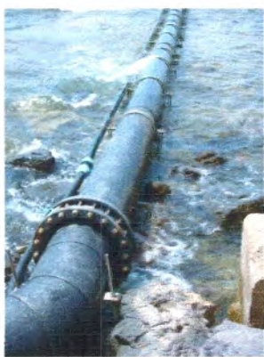
Figure 41 : Action de pompage des eaux de mer brutes et rejets liquides par la station de dessalement d'Oued Abdallah. (Photos. Belhadj. 26/07/2006).
