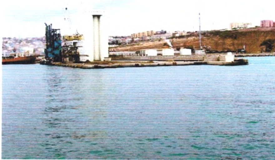
Figure 32: Vue générale d'ALZINC à partir du port. (M.A.T.E, 2006)
