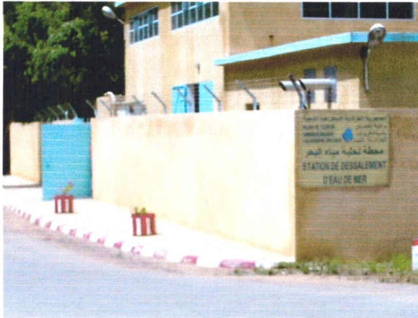
Figure 36 : Vue de la station de dessalement à Oued Abdellah (Photo Belhadj, 10/07/2006).
