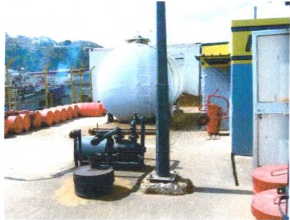
Figure 39 : Vue du poste d'approvisionnement en carburant - Port de pêche Ghazaouet. (M.A.T.E, 2006)
