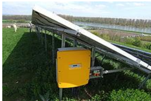
Figure I-34 Un ondeleur pour une centrale solaire photovoltaïque.[28]
