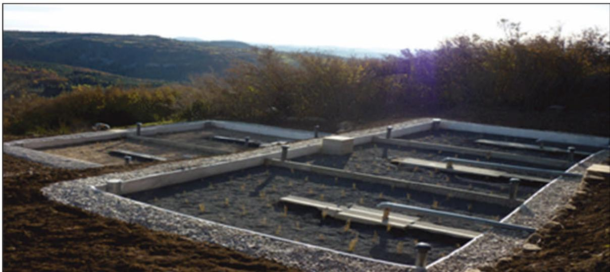
*Figure II.9: Système d'épuration mixte avec trois bassins à écoulement vertical en 1er étage et deux bassins à écoulement horizontal en 2ème étage (J.B. Poulet, A.Terfous, et all, 2004).*
