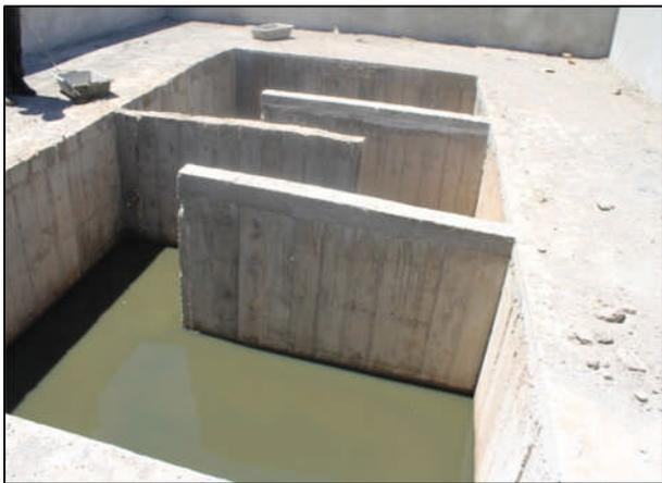
*Figure IV.10 : Bassin de décantation de L'AS SEHB et OULED BOUNOIRE.*
