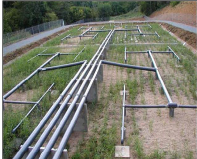
*Figure IV.11 : Alimentation en surface des filtres verticaux de la Station Saint Laurent (France).*
