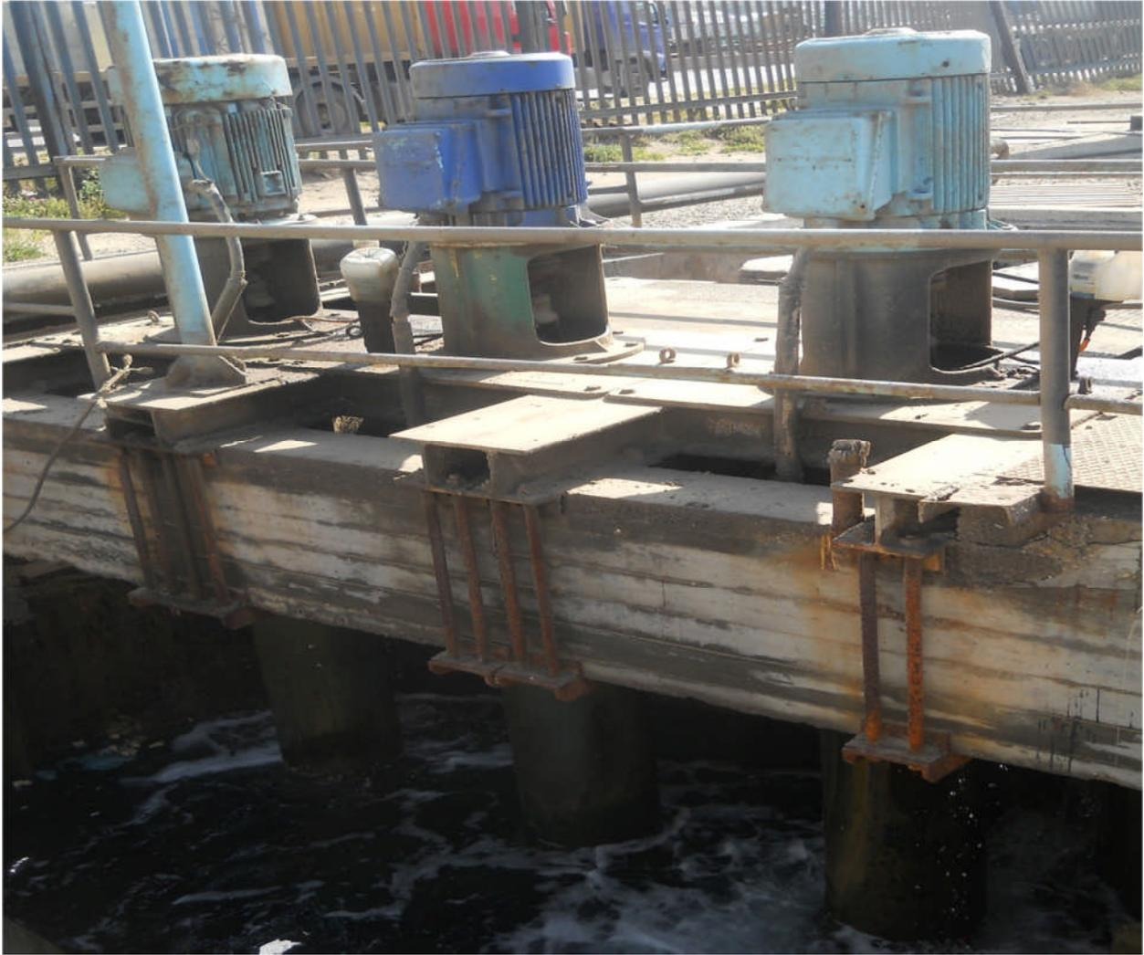
Figure I.7 : Les pompes centrifuges de reprises
