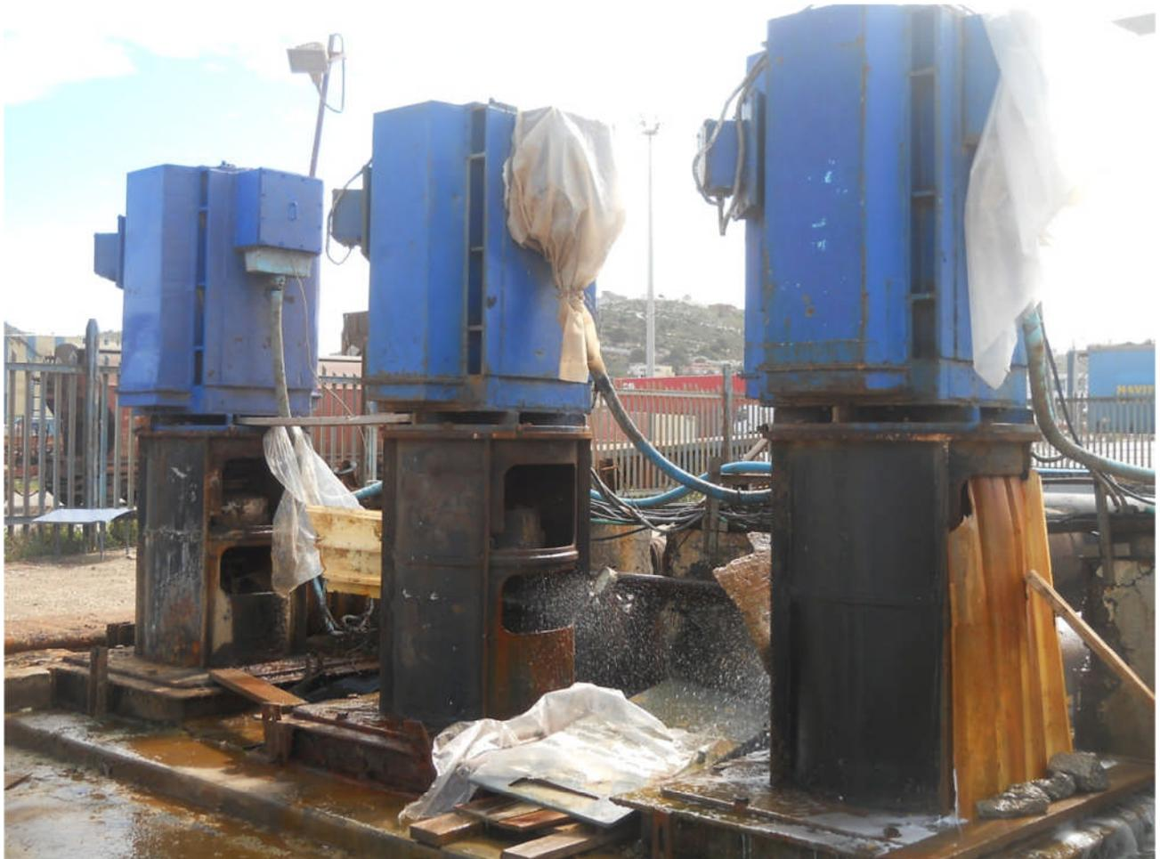
Figure I.8 : Les pompes centrifuges principales
