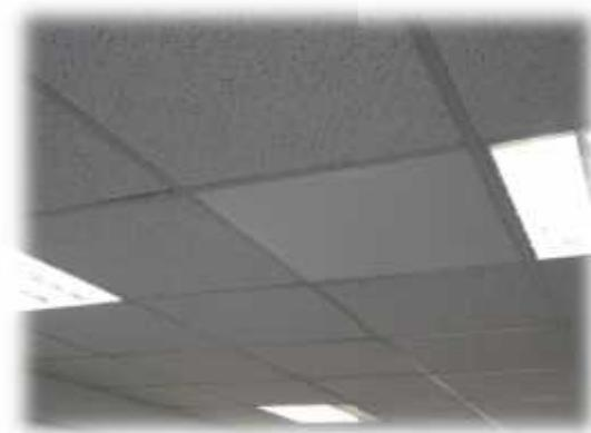
Il est réalisé en plaque perforé de 2cm d'épaisseur avec une couche supérieure de laine de verre (pour éviter la propagation du feu) couverte d'une tôle d'acier galvanisé. L'ensemble est posé sur une structure légère en profilé d'aluminium qui est accrochée directement au plancher.
