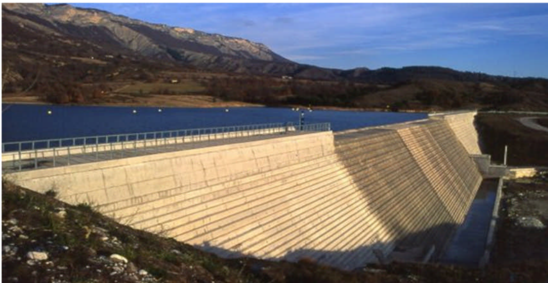
Figure I-4 : Barrage du Riou-BCR
