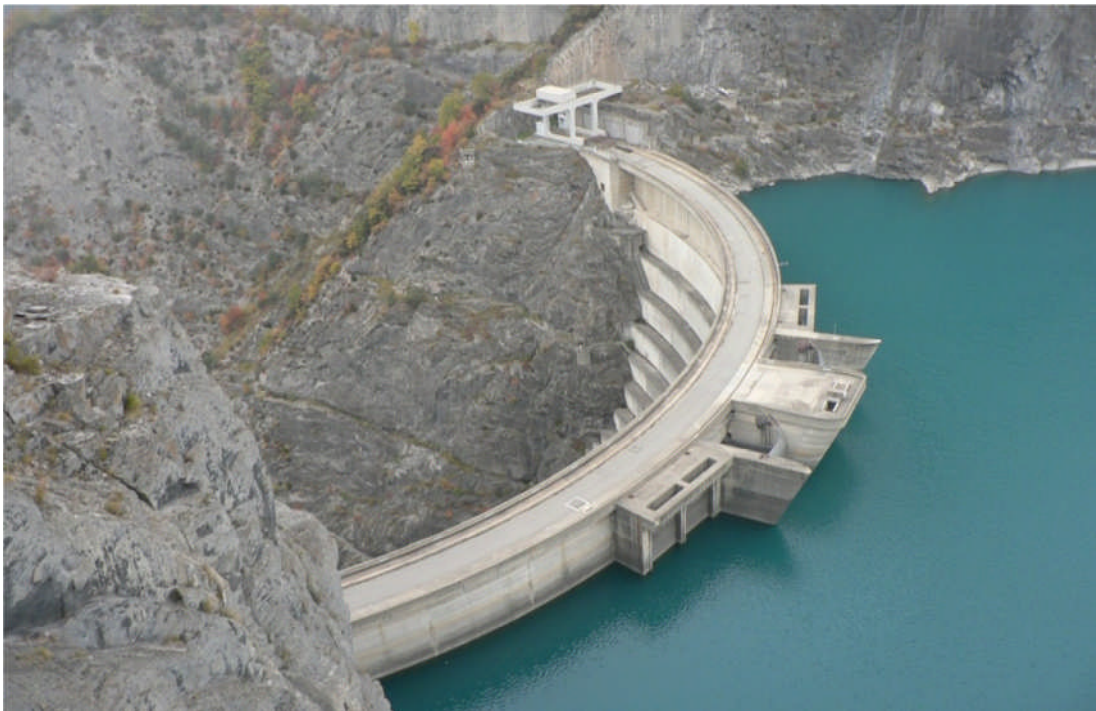
Figure I-2 : Le barrage de Monteynard (Isère, France)- voûte
