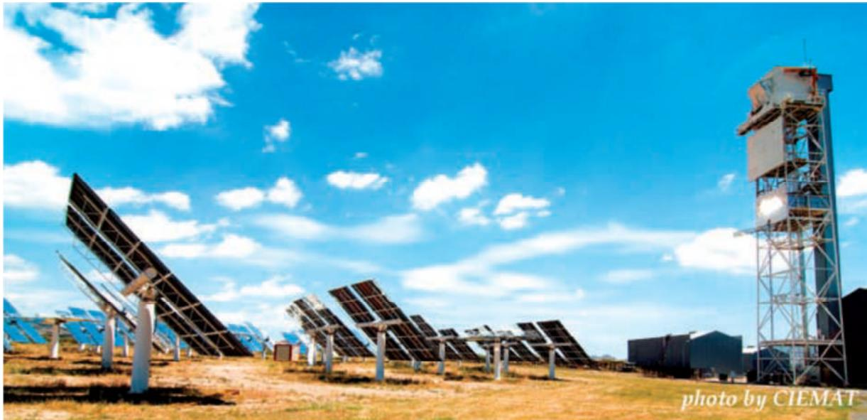
**Figure.12. La centrale solaire thermochimique d'hydrogène, avec la tour solaire où le réacteur HYDROSOL-II mise à l'échelle est installé à la Plate forme Solaire de Almeria, en Espagne.**
