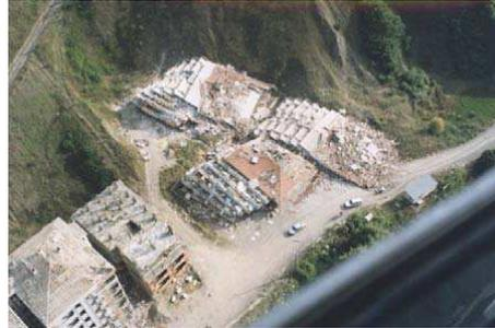
**Figure 6.** Effondrement par manque de ductilité
