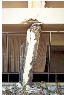
**Figure 4.** *Disposition incorrecte des cadres*
