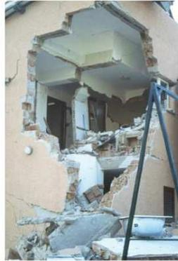
**Figure 1.** *Maçonnerie non chaînée*
