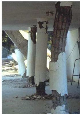
**Figure 3.** *Poteaux de géométrie élancée a subi une flexion globale*
