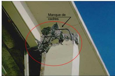
**Figure 5.** Eclatement du nœud par manque de frettage
