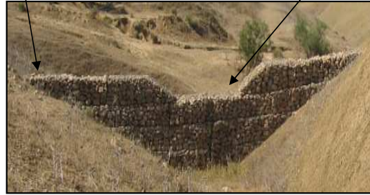
Photo n° 08 Seuil en gabion
