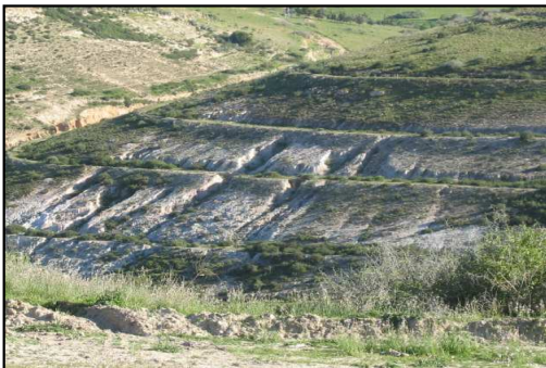
Photo n° 23 Réseau de banquette attaquée par le ravinement : le débordement des eaux a provoqué la rupture du bourrelet
