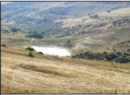
Photo n° 26 Seuil en terre très stable
