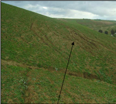
Photos n°03 Érosion en rigole
