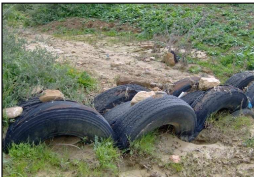
Photo n°11,12 .Seuil en pneu utilisé sur terrain marneux
