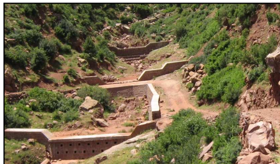
Photo n° 10 Seuils en béton
