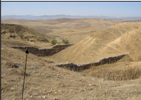
Photo n° 30 Seuil en Gabion surdimensionné Bounakhla-Heriz
