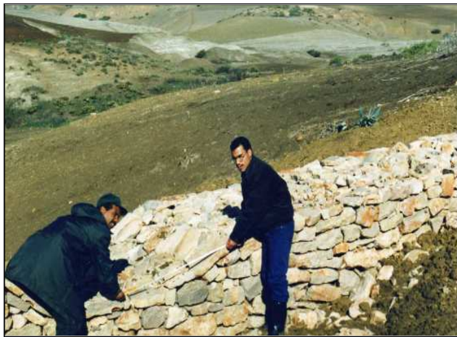
Photo n°25 Mesure d'un seuil à l'amont du barrage de Sidi EL Abdelli
