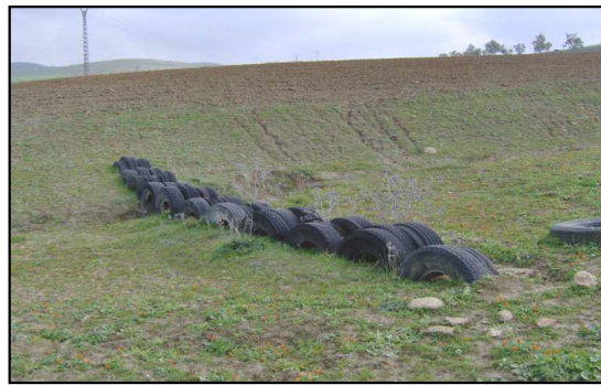
Photo n°11,12 .Seuil en pneu utilisé sur terrain marneux
