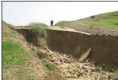
Photo n° 28 ,29 Dégradation de la digue et du déversoir du seuil en terre
