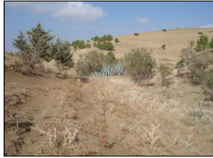
Photo n°33 fixation biologique des versants marneux : utilisation d'un mélange d'espèces (Pin d'Alep, et cyprès dans la zone d'étude
