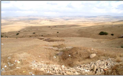
Photo n° 07 Seuils en pierre sèche utilisée dans la fixation des ravines
