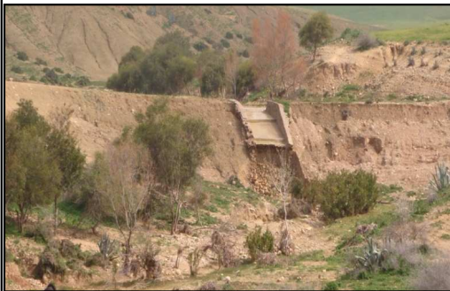
Photo n° 28 ,29 Dégradation de la digue et du déversoir du seuil en terre
