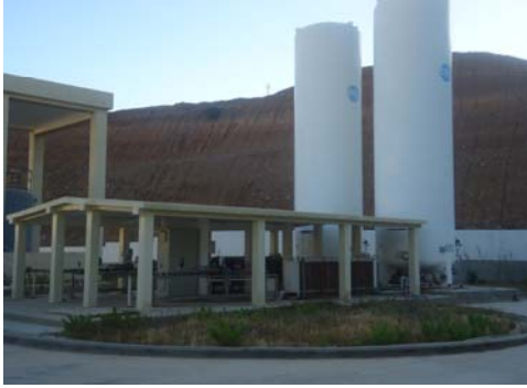
Figure 16: Système de dosage du CO 2
