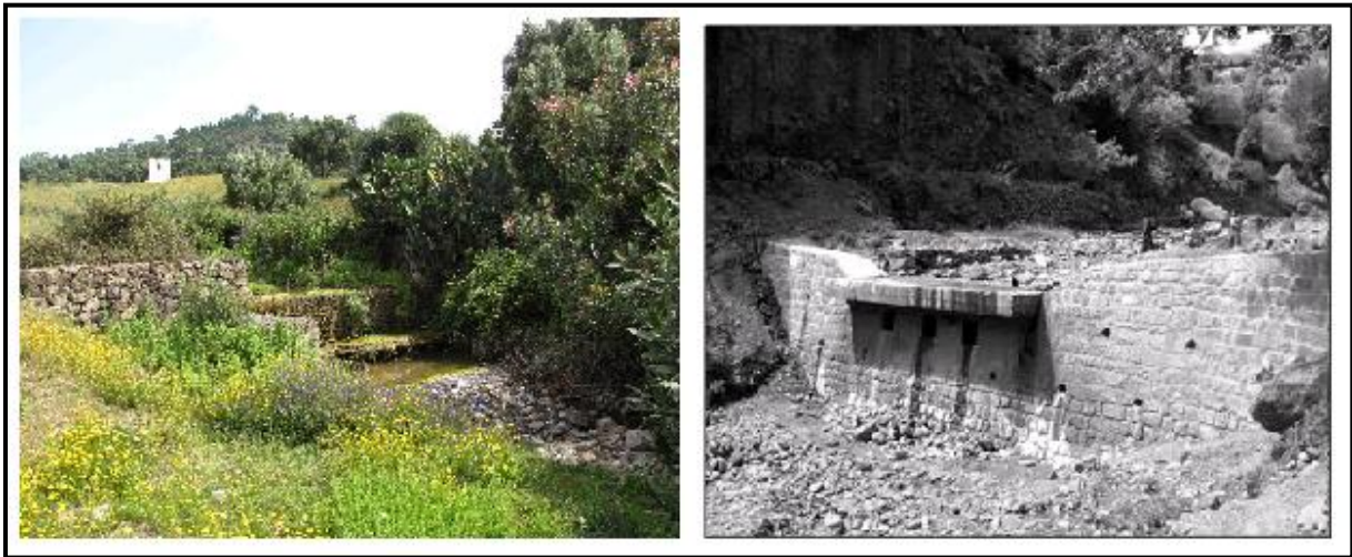
Photo IV.12 : Traitements des ravines par un Mur en gabions (TALON.A D. BOISSIER, L. PEYRAS .2009)
