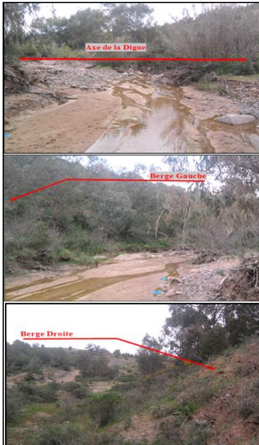
Photo IV.4 : Implantation de la digue (BENMIA kouider 2012)
