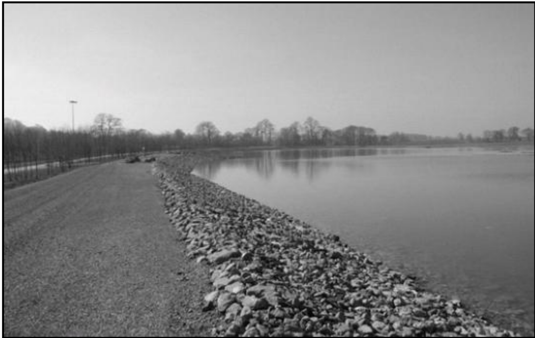
Photo .IV.7 : Protection des berges classique contre l'inondation. (BESSION 2007).
