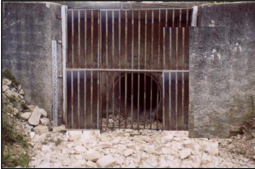
Photo IV.5: Entrée du collecteur enterré en amont immédiat de la zone à habitat dense (Cemagref - 2010)
