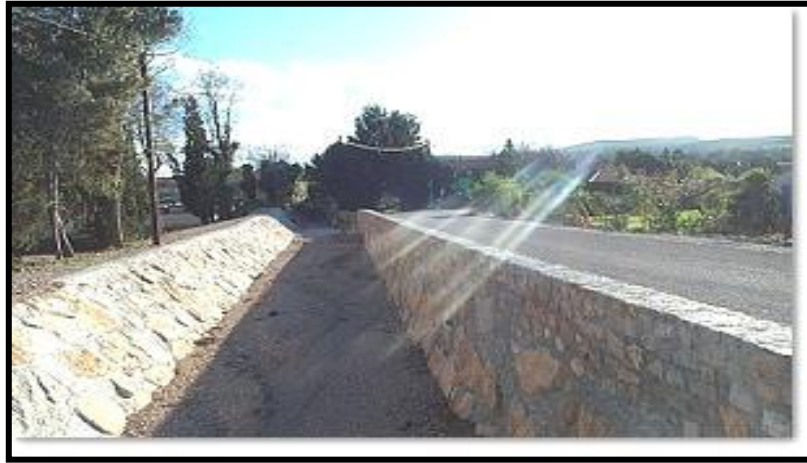
Photo II.2 : Enrochement à Thuir (la trencade - France). (BOULGHOBRA – 2006)
