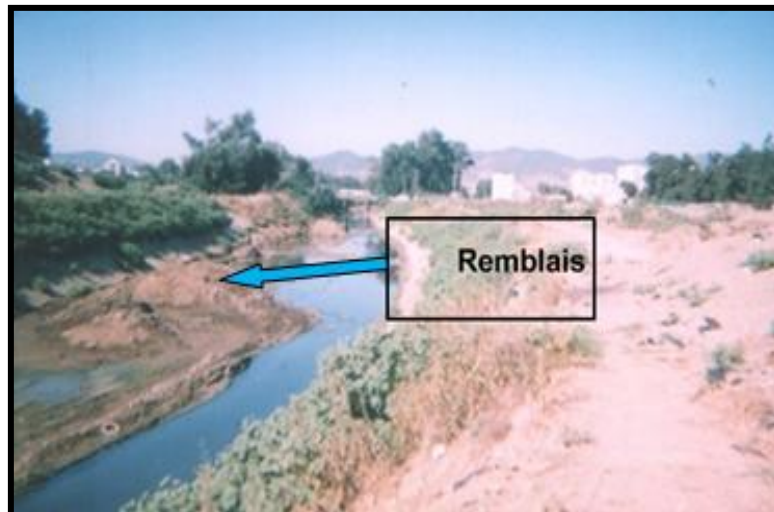
Photo II.1 : le jet des remblais dans les cours d'eau aboutit à des inondations liées aux embâcles (oued Zeramna prêt de la zone industrielle -Skikda -août 2005) (BOULGHOBRA – 2006)
