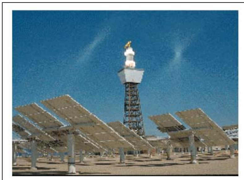
Fig. (1.6): Système de la centrale à tour.
