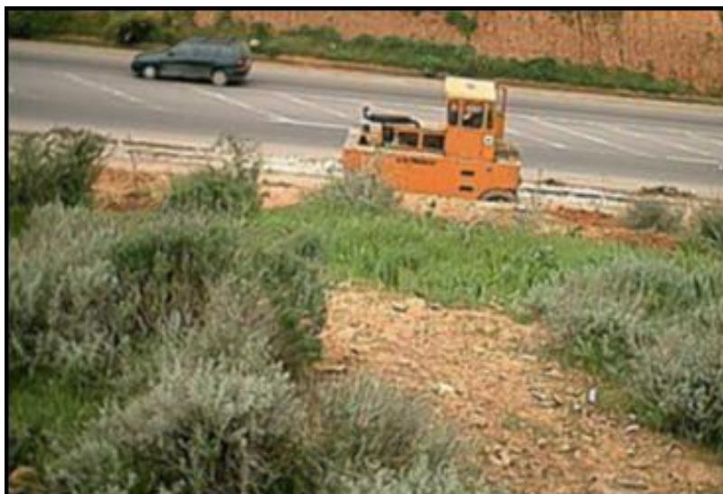
Photo 3: station de Remchi .Travaux d'élargissement de la RN 22 (Disparition D'une partie de l'Atriplexaie). Aboura (2006).
