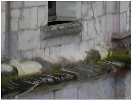
Figure 8 : Détail d'une partie altérée de la tour du Chaudron issu de la photomodélisation
