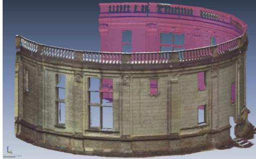
Figure 7 : Rendu général de la tour du Chaudron par laser scanner
