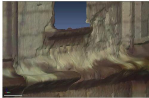
Figure 9 : Détail d'une partie altérée de la tour du Chaudron issu du scanner laser
