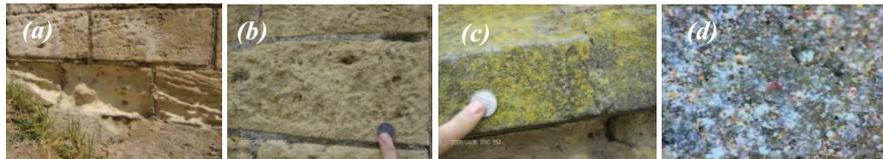
**Photo 3.** Morphologies d'altération, (a) : érosion et alvéolisation, (b) : désagrégation et perforation par des micro-organismes, (c) : algues et lichens, (d) : algues, lichens, champignons mis en évidence par le Vidéo-microscope
