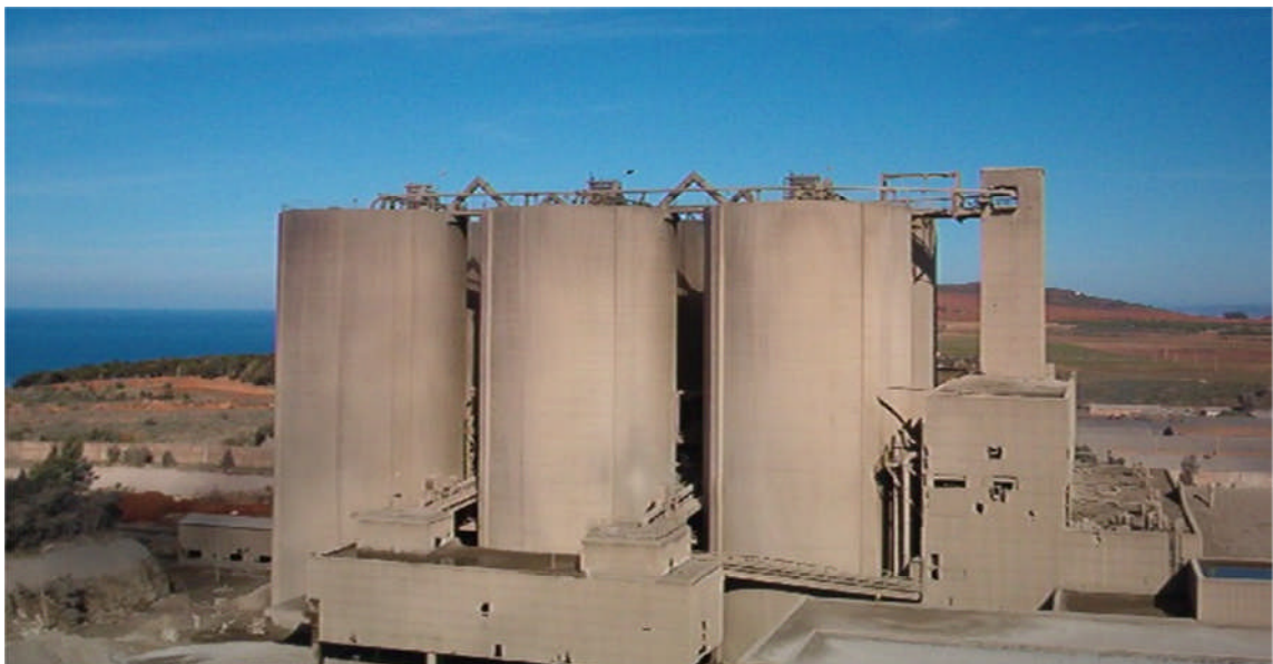
Figure 1.19 : Les silos de ciment de la cimenterie de Béni-Saf.
