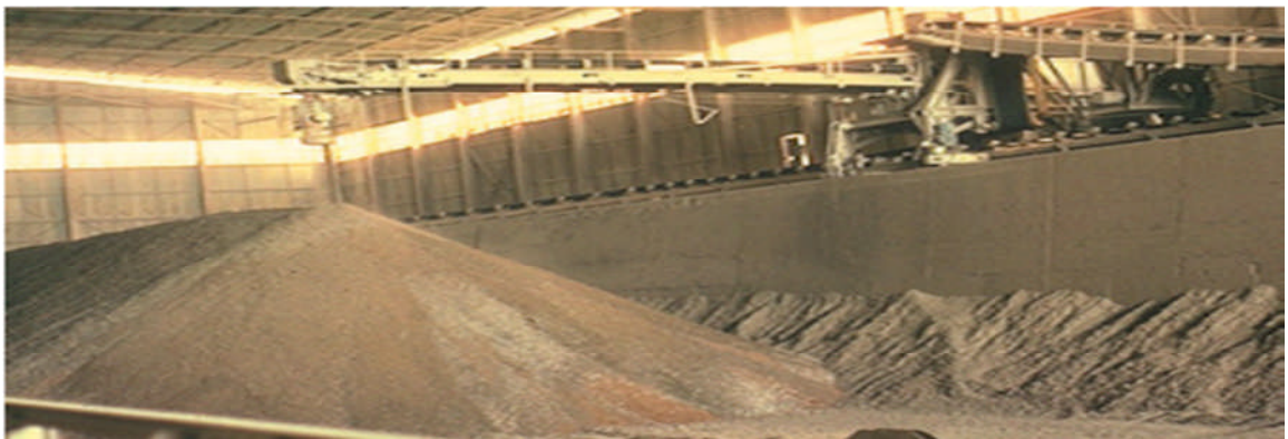
Figure 1.8 : La pré-homogénéisation roues-pelles [18].
